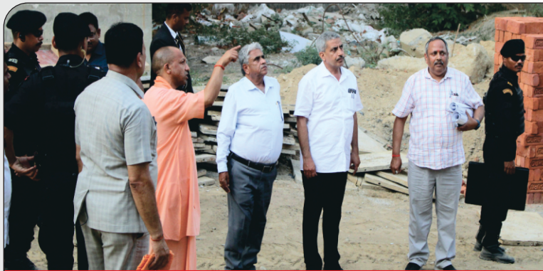
09 निर्माणाधीन फार्मास्युटिकल भवन का निरीक्षण करते माननीय कुलाधिपति महोदय
