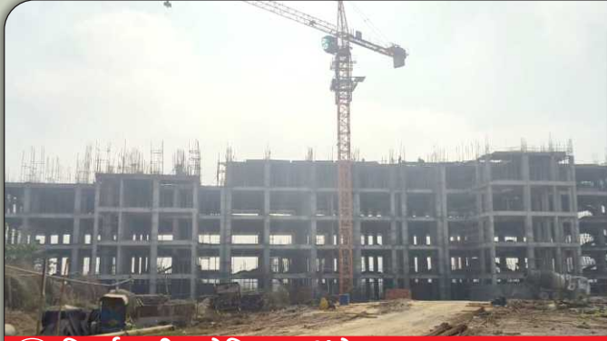
03 निर्माणाधीन मेडिकल कॉलेज
